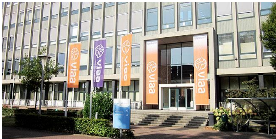
VIAA főiskola bejárata
